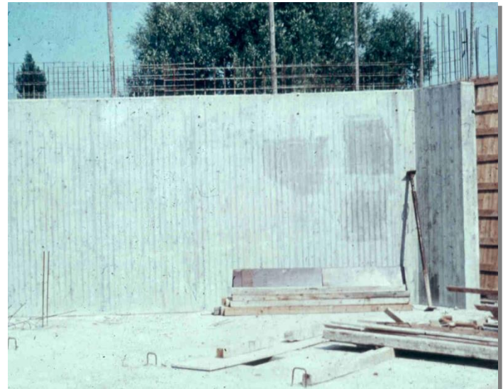
Hergebruikte bekisting, tweede stort zonder sparingen
